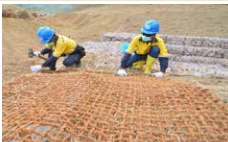
Pemasangan jute net Installation of jute net
