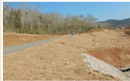
Penggunaan jerami untuk mempertahankan kelembaban / Use of straw as moisture retainer
