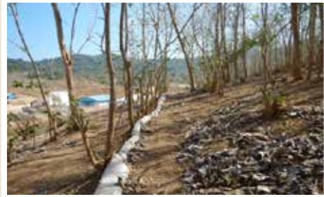
Bantalan batuan yang ditempatkan pada lereng Rock pillows placed on downhill slopes
