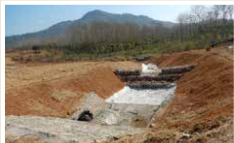
Perangkap sedimen struktur Gabion pada dasar aliran yang lebih besar / Gabion structure sediment traps at the base of larger streams
