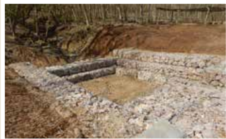
Perangkap sedimen struktur Gabion pada dasar aliran yang lebih besar / Gabion structure sediment traps at the base of larger streams
