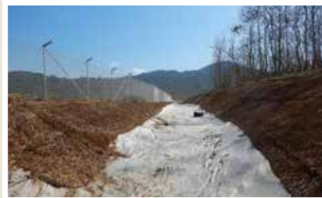
Saluran aliran air yang dipasangkan dengan geotextile / Water flow channels lined with geotextile
