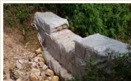
Saluran aliran air yang dipasangkan dengan geotextile / Water flow channels lined with geotextile
