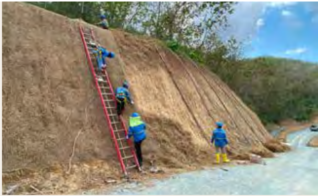
Pemasangan jaring rami (kiri) dan Hydroseeding (kanan)
